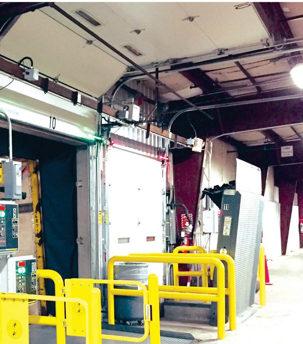
versões automáticas oferecem a vantagem adicional de estabilizar o baú. Essa é uma vantagem especial dos equipados com suspensão a ar que tem a tendência de sacudir quando as empilhadeiras entram no veículo.
