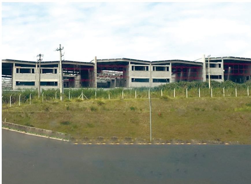
Galpões com construção interrompida
