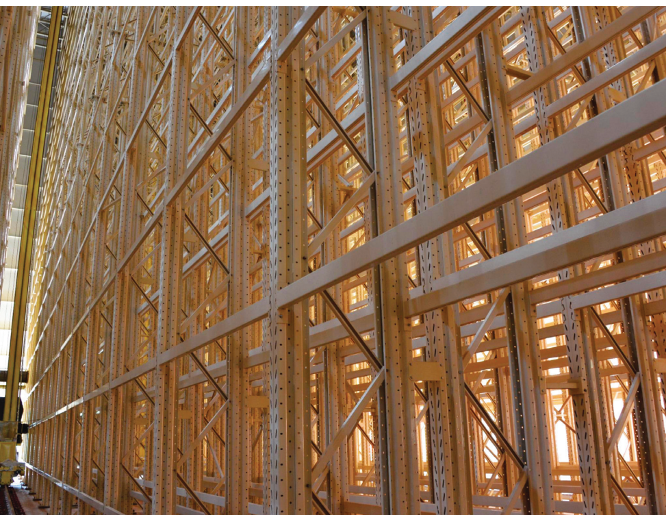
Quatro transelevadores da Scheffer operam no CD
